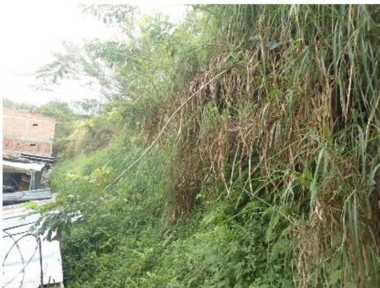
Figura 11. Cobertura vegetal del talud.
