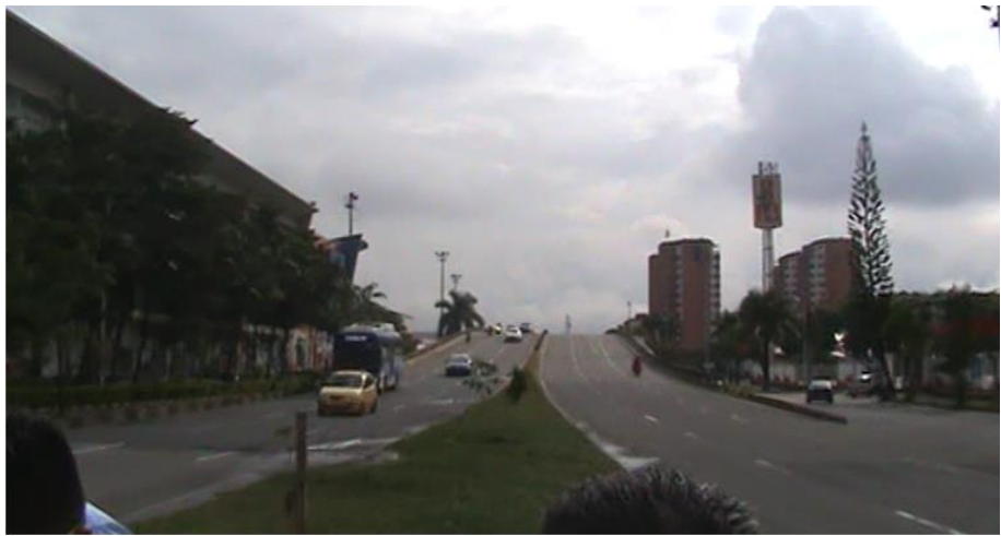
Transformación subterránea a box culvert. Carrera 80 con calle 13.
