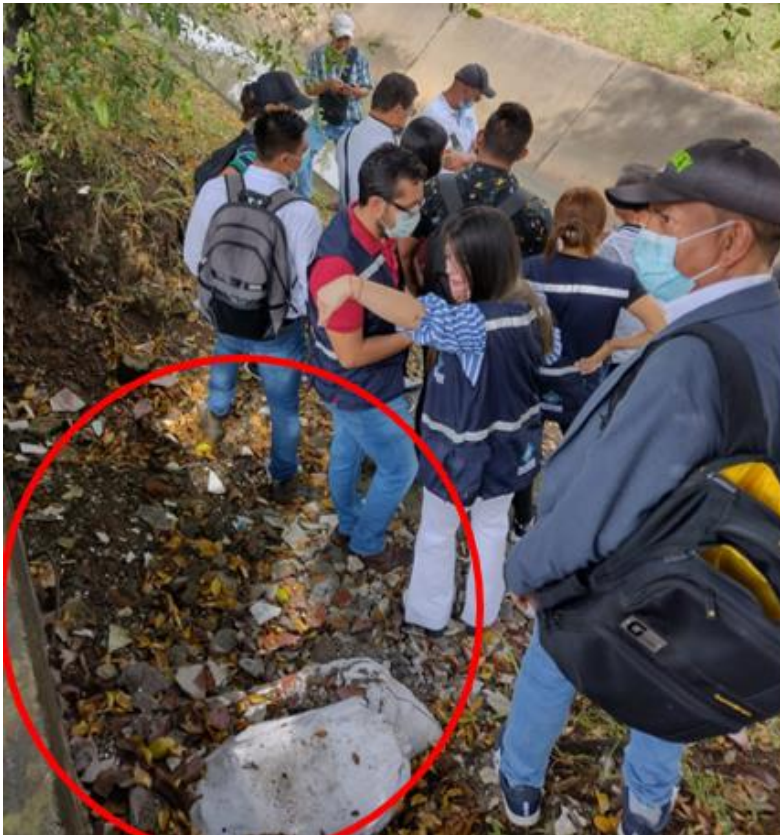
Canal Nápoles Calle 13 cerca a la carrera 5ª.
